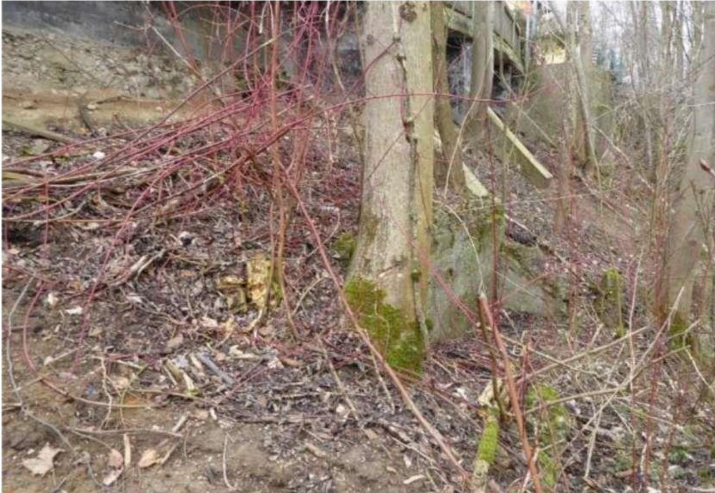
Ansicht der Stützwand von unten.
