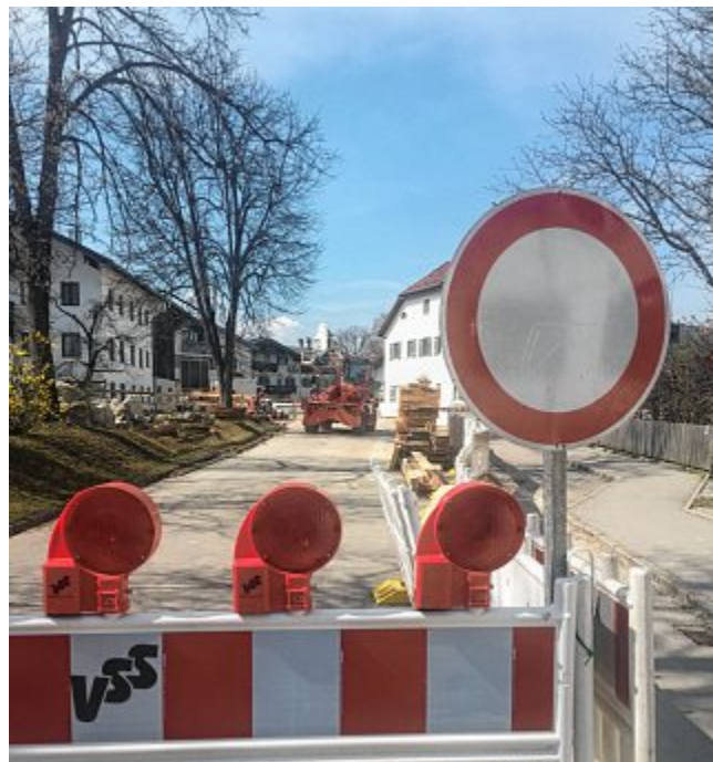
Nichts geht mehr für den Straßenverkehr durch Au. Vier Bauabschnitte hat die Sanierung der Brücke.
