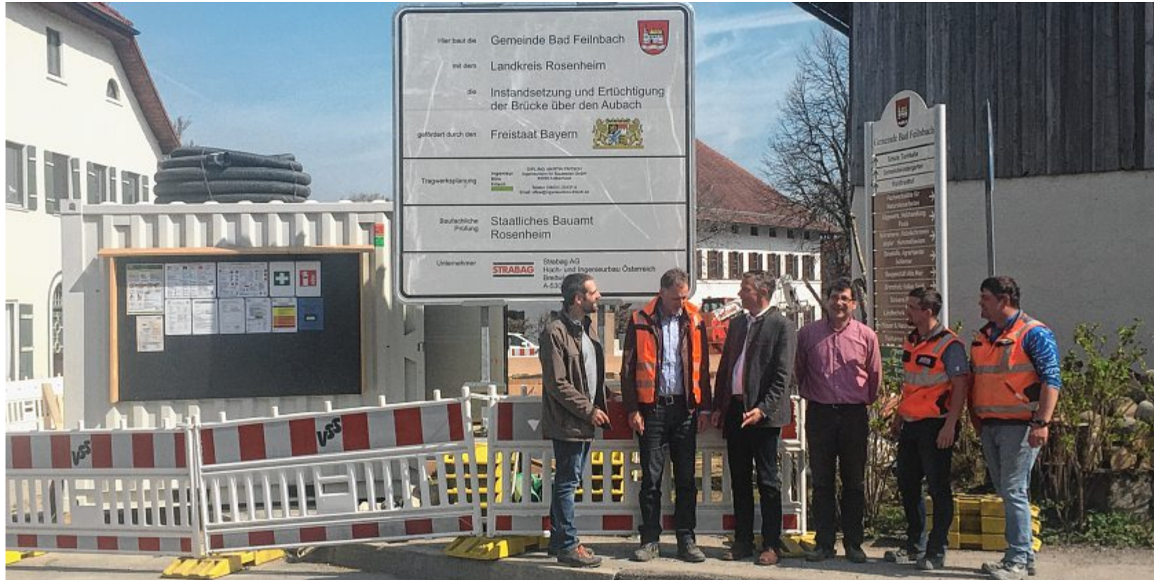
Offizieller Startschuss für die Sanierung der Aubachbrücke (von links): Jonas Loebell und Martin Fritsch (beide Ingenieurbüro Fritsch), Bürgermeister Anton Wallner, Peter Feldschmidt (Bauamt) sowie Alexander Dürager und Bernhard Saubach (Firma Strabag). FOTOS MISCHI
