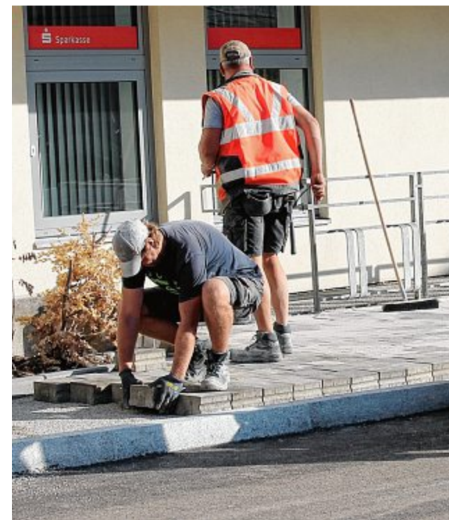
Bis auf wenige Restarbeiten ist die aufwendige Sanierung technisch abgeschlossen.
